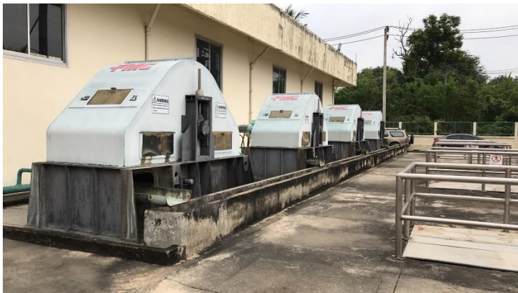
Traveling screen เป็นตะแกรงหมุนได้เพื่อป้องกันการอุดตันสิ่งมีชีวิตขนาดเล็กหลุดเข้าไป
